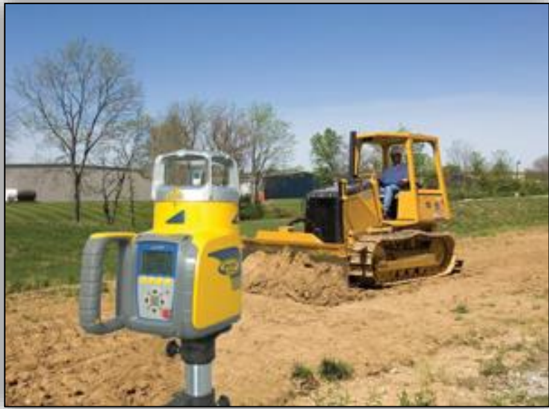
រូបទី៧ ការកៀរពង្រាបដីដោយប៊ូលដូហ្សែរ បំពាក់ប្រព័ន្ធឡាហ្សែរ
